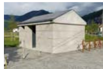
Un local technique a été construit avec le béton des anciennes usines.
