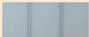
Couverture en zinc à joint de bout, finition pré patinée
